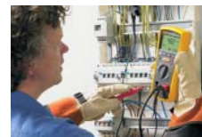
Test izolace na deskovém rozvaděči
